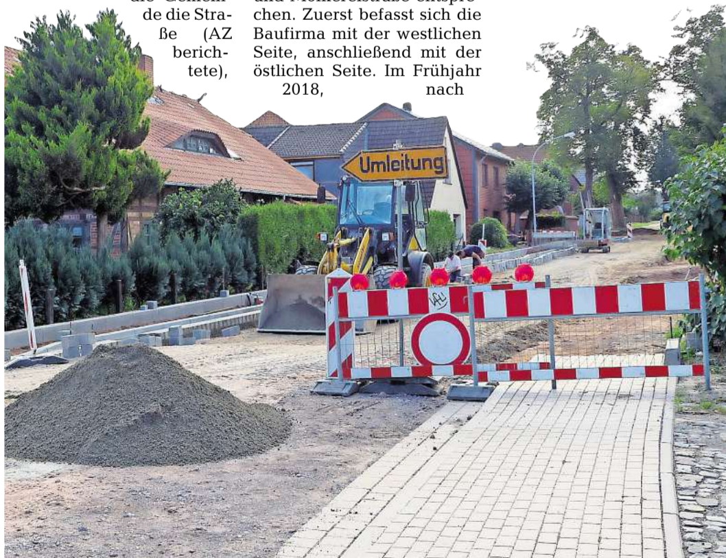
Alles im Plan: Etwa ein Viertel der Bauzeit ist um, an der Lindenstraße wird zurzeit der nördliche Gehweg gemacht.
